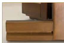
Standard: gocciolatoio ricavato sul telaio
