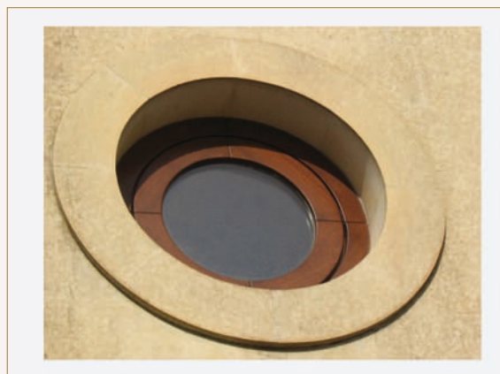
Esempio di oblo con apertura a bilico
